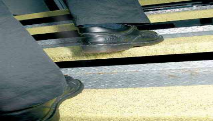
Şekil A.6.6: Kaymaz zemin kaplamalı merdiven örneği
